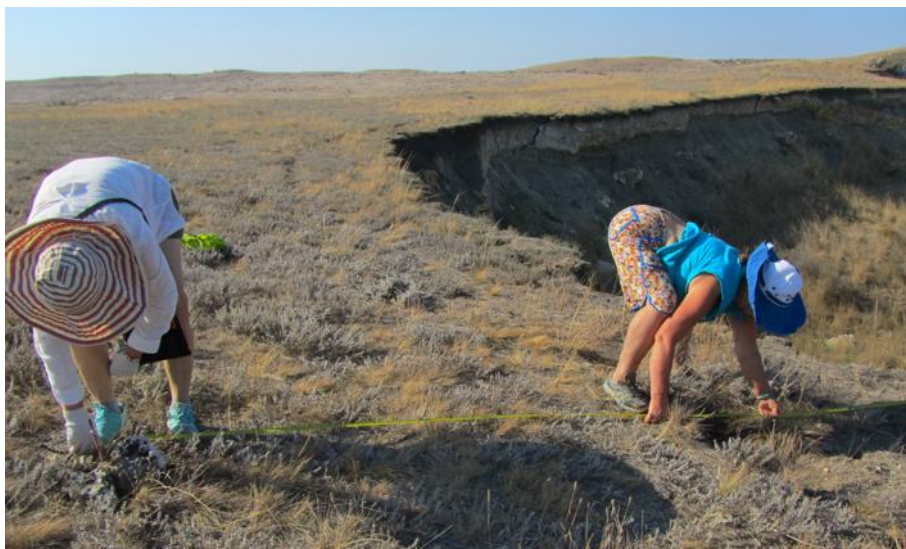
Рис. 4: Многочисленные линии отрыва (сверху): Замеры расстояния от репера М4 (слева) до трещины отрыва (справа) над разрезом правого борта (внизу).
